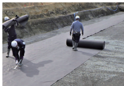
1 保護シート敷設
