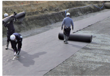
1 保護シート敷設
