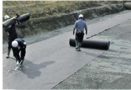
1 保護シート敷設
