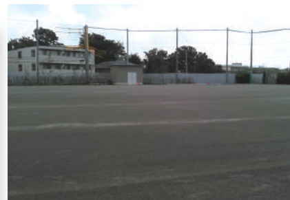
9 上部利用施設(学校グラウンド)
