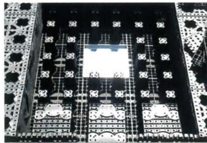
4 点検孔(土砂捕捉水透過壁)
